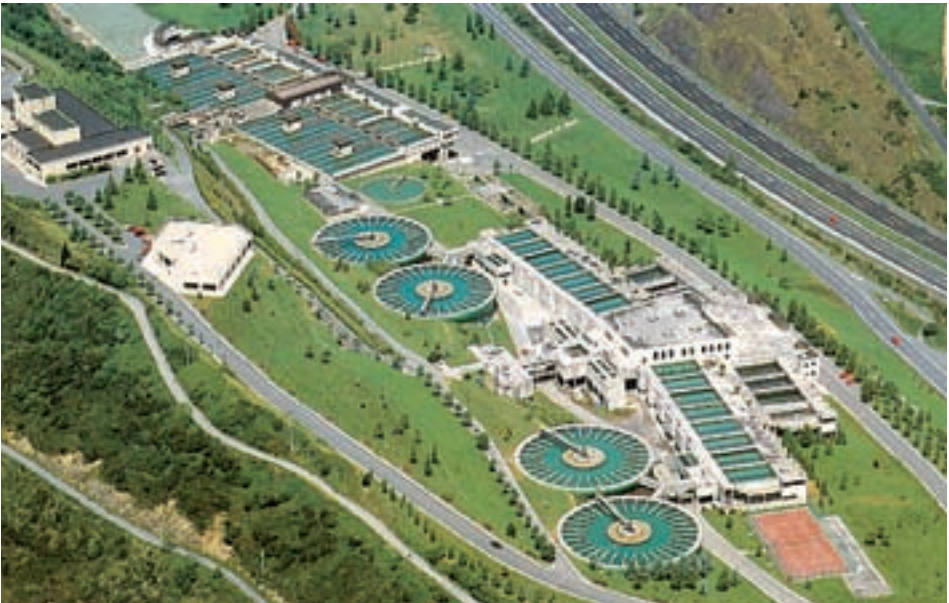
FOTO 18.6: Vista aérea de la Estación de Tratamiento de Agua de Venta Alta
