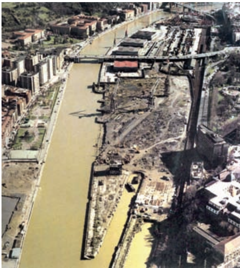
FOTO 19.4: Actuación de demolición de ruinas practicada en el astillero Euskalduna (1995)
