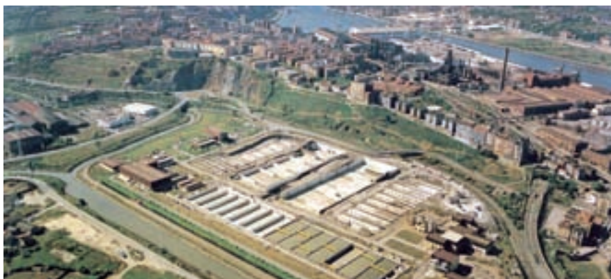
FOTO 19.12: Vista aérea de la EDAR de Galindo, Sestao y la Ría de Bilbao, 1996
