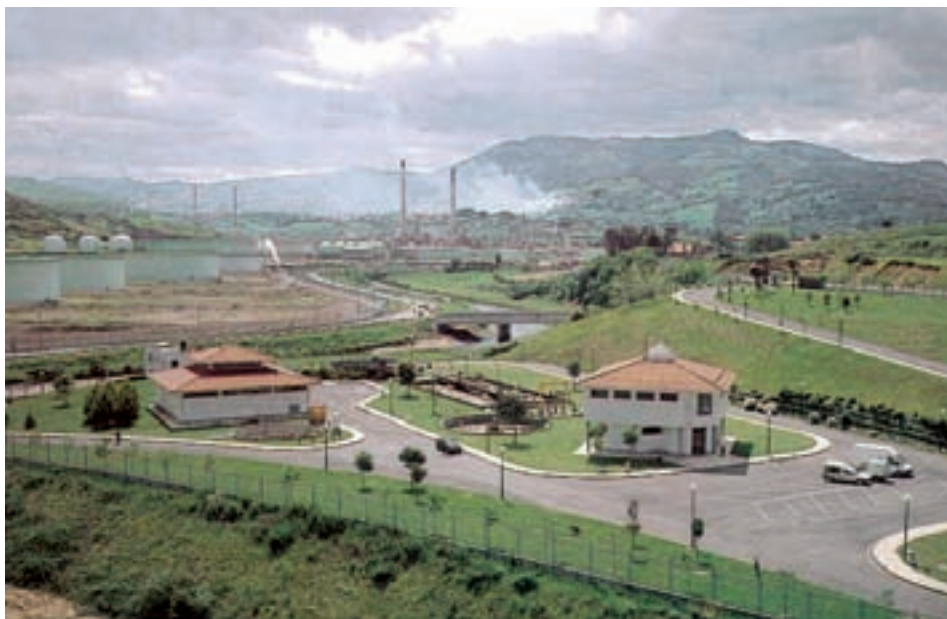
FOTO 19.11: Estación depuradora de aguas residuales de Muzkiz
